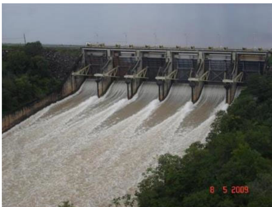
Figura 150. Detalhe do Vertedouro da UHE Boa Esperança. Fonte: Jornal Cidade Verde, acesso em abril/2018
