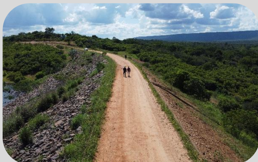
CRISTA DA BARRAGEM DE ALGODOES II - CURIMATÁ/PI
