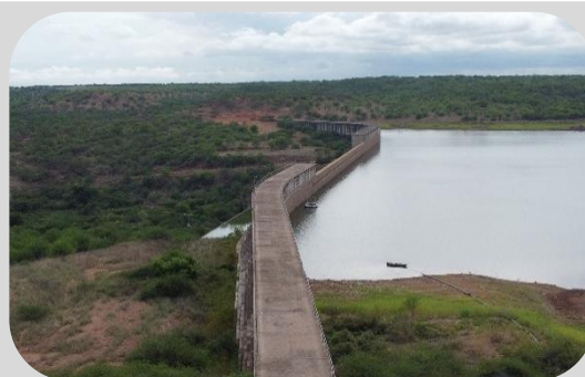
BORDA LIVRE - BARRAGEM DE POÇOS MARRUÁ - PATOS DO PIAUÍ/PI
