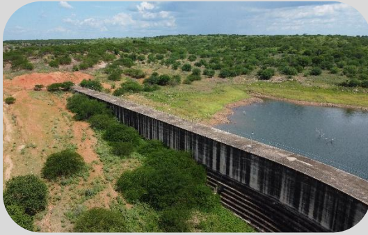
OMBREIRA - BARRAGEM DE POÇOS MARRUÁ - PATOS DO PIAUÍ/PI
