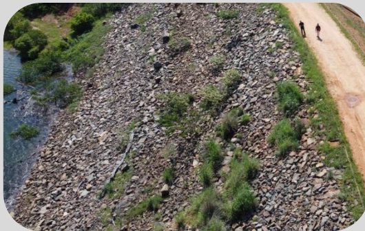
RIP-RAP - TALUDE MONTANTE - BARRAGEM DE ALGODÕES II - CURIMATÁ/PI
