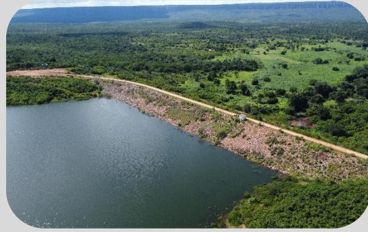
TALUDE MONTANTE - BARRAGEM DE ALGODÕES II - CURIMATÁ/PI
