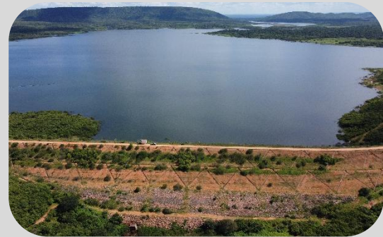
CANALETAS - TALUDE JUSANTE - BARRAGEM DE ALGODÕES II - CURIMATÁ/PI
