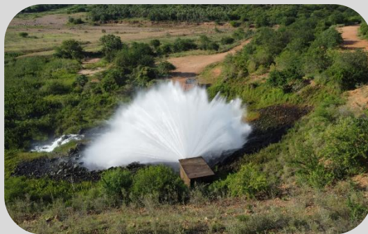
VALVULA DE DISPERSÃO - BARRAGEM DE PEDRA REDONDA - CONCEIÇÃO DO CANINDÉ/PI
