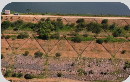
TALUDE JUSANTE - BARRAGEM DE ALGODÕES II - CURIMATÁ/PI
