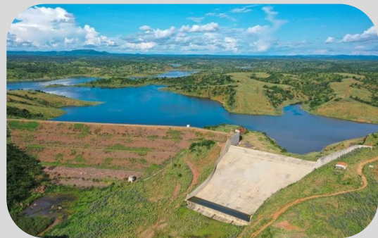
VERTEDOIRO - BARRAGEM DE PIAUS - SÃO JULIÃO/PI
